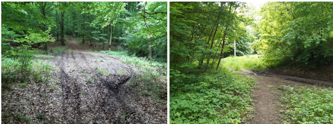
Obrázok 403 Poškodená účelová komunikácia
