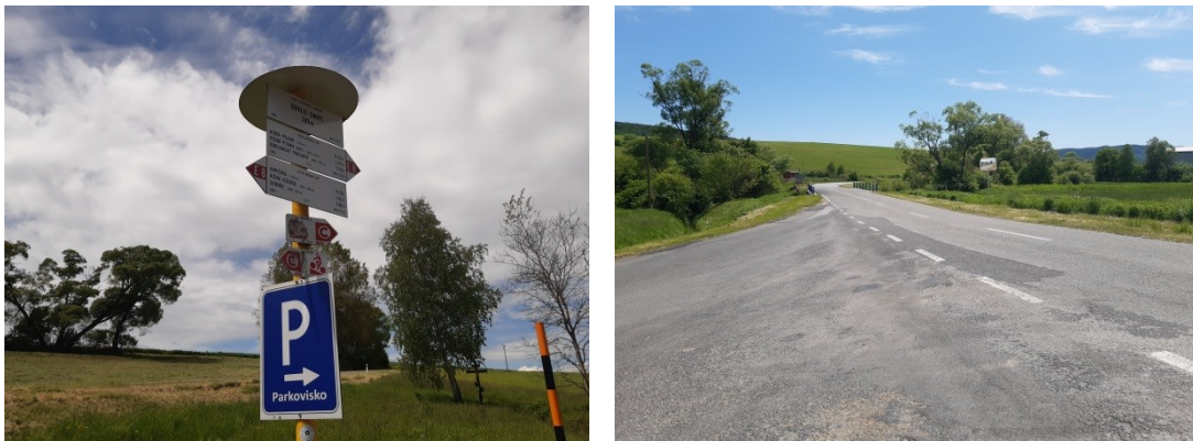
Obrázok 223 Predmetné poškodené cyklosmerovky
