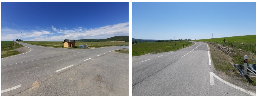
Obrázok 161 Predmetná križovatka s chýbajúcim značením
