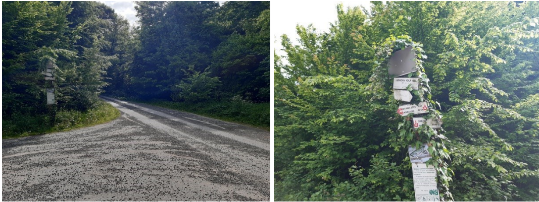
Obrázok 114 Predmetné poškodené cyklosmerovky
