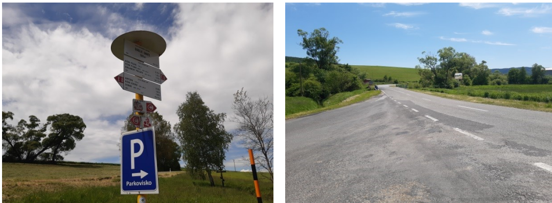
Obrázok 229 Predmetné poškodené/chýbajúce cyklosmerovky
