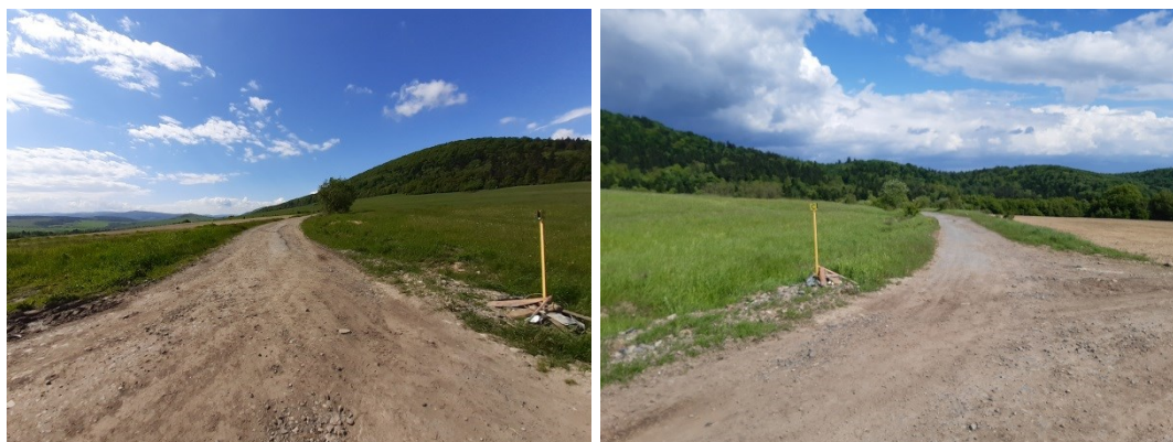
Obrázok 55 Predmetný poškodený cyklosmerovník
