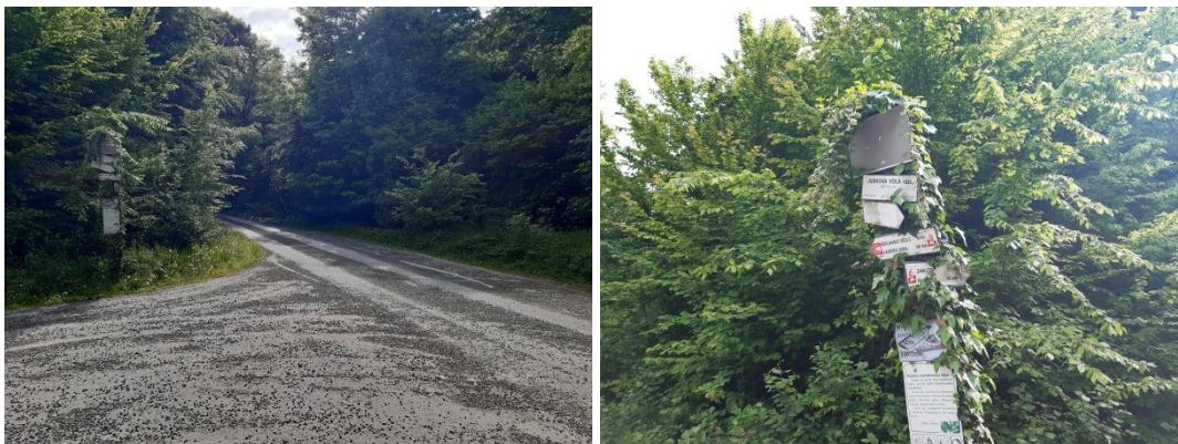
Obrázok 129 Predmetné poškodené cyklosmerovky
