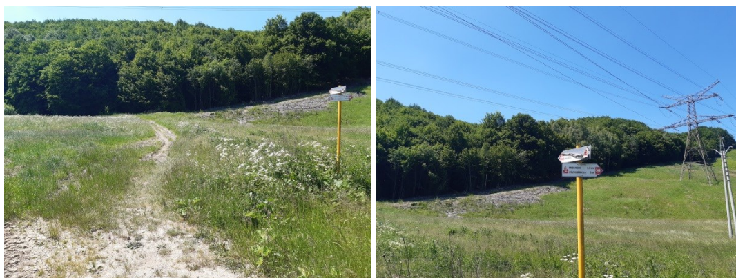
Obrázok 249 Predmetné poškodené cyklosmerovky
