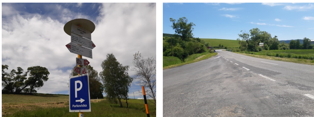
Obrázok 218 Predmetné poškodené cyklosmerovky
