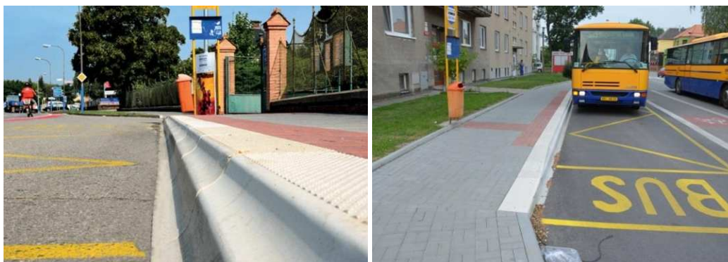
Obr. 6.1.8 Bezbariérové zastávky MHD - detail Kasselský obrubník; Zdroj: 15
