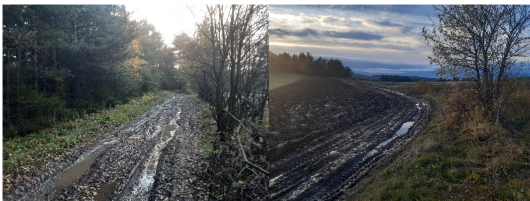
Obrázok 60 Lesné cesty poškodené prejazdom traktorov a motoriek
