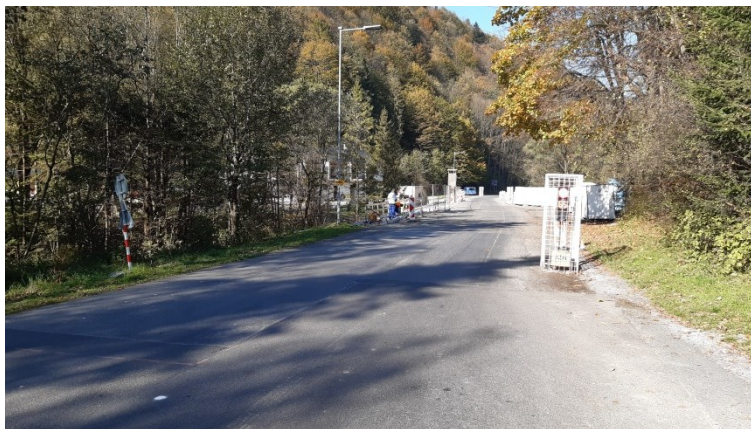
Obrázok 83 Rekonštrukcia mostného objektu
