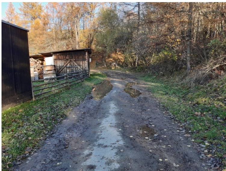
Obrázok 67 Nevhodná odvodňovacia mreža
