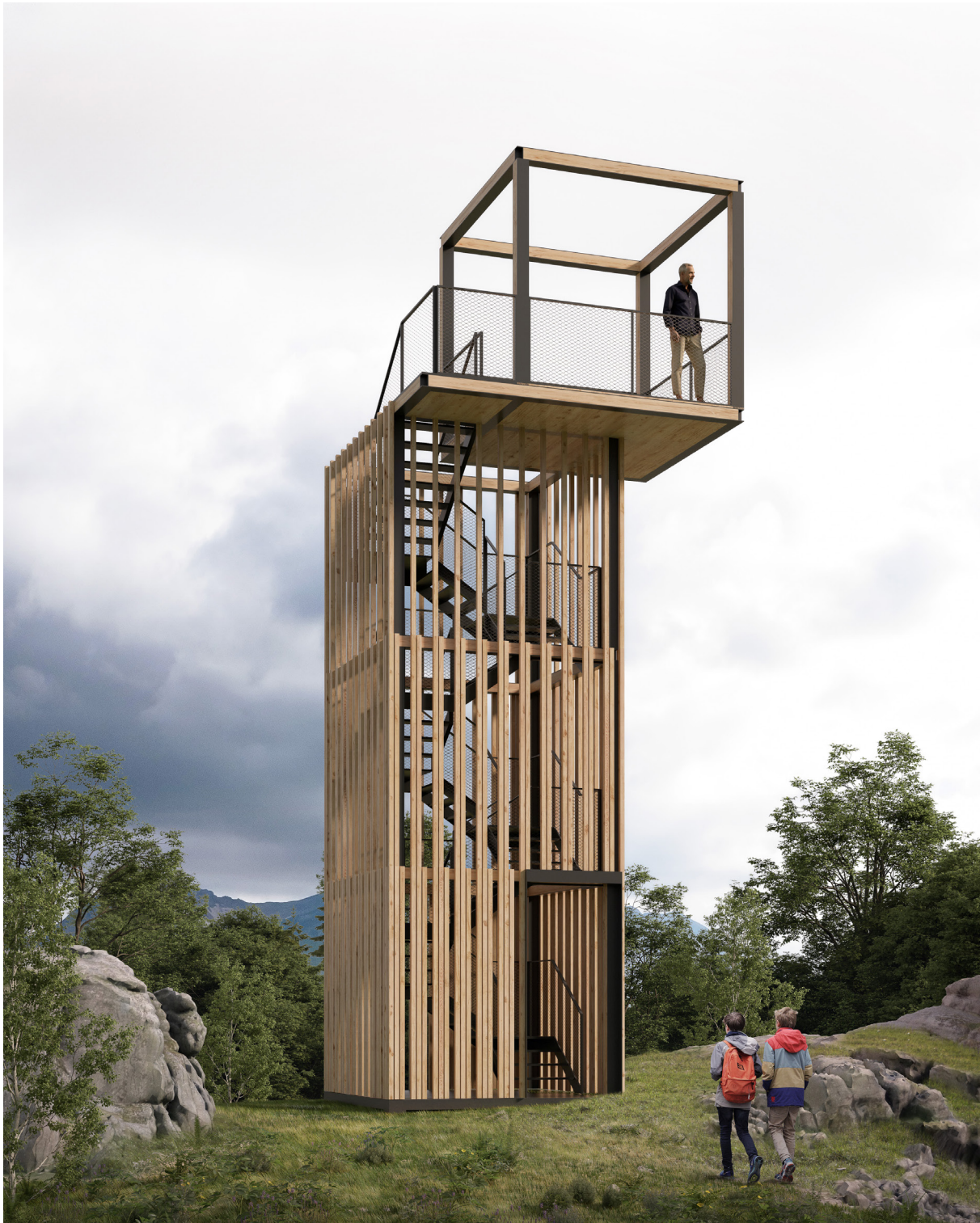
Telo veže je obložené drevenými lamelami, ktoré nielenže podporujú prírodný vzhľad, ale aj ponúkajú široké možnosti pre grafické stvárnenie, ako aj pre aplikovanie regionálnych symbolov a značiek.
