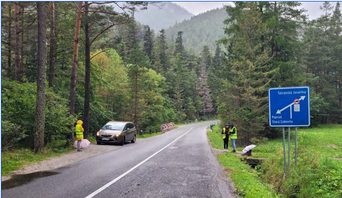
Obrázok 30 Práca brigádnikov na stanovišti č. 10 na ceste III/3077 medzi Lendakom a T. Kotlinou
